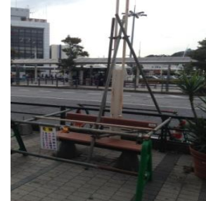
老朽化した街路灯
