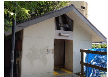
昭和59年築の公衆トイレ
